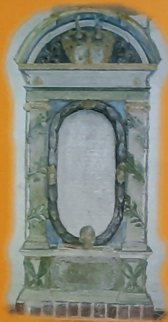
Epitaph nach der Restaurierung durch die Firma Krappele 2007
